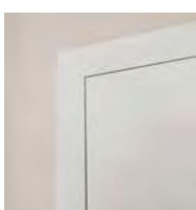
De strakke look wordt gecreëerd door de deur en het kassement in hetzelfde vlak te plaatsen en de rechte omlijstingen te integreren in het frame met rechte hoeken.
