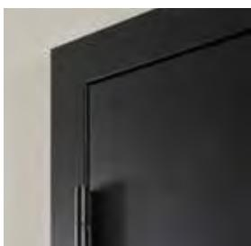
Omlijsting in verstek, deur en omlijsting in hetzelfde vlak
