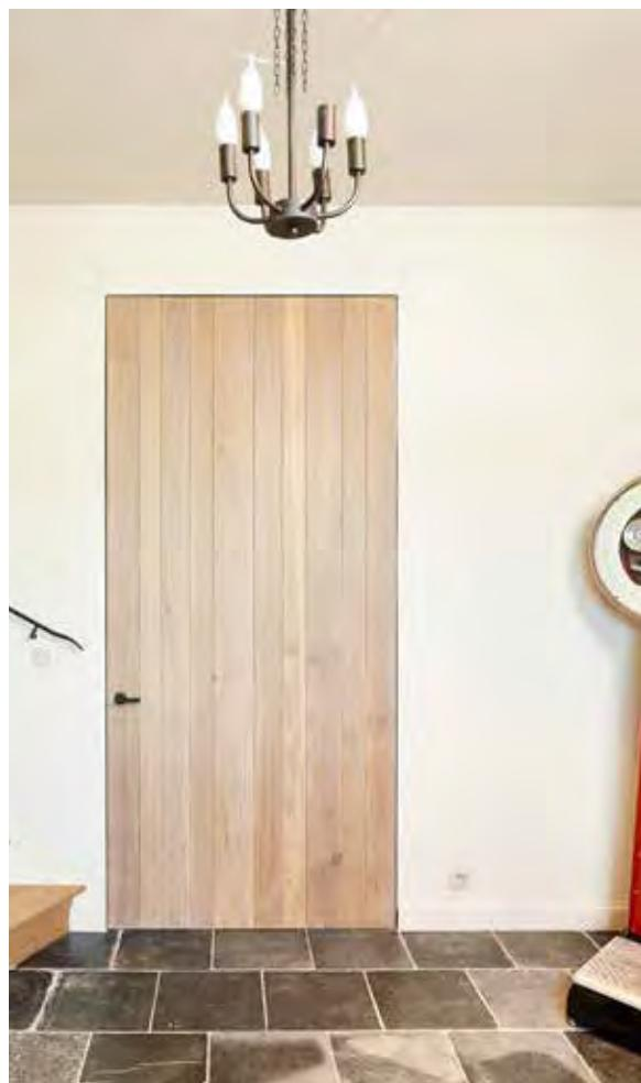
Stalen kassement met onzichtbare scharnieren
